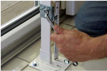
untere Aufhängevorrichtung positionieren und befestigen
