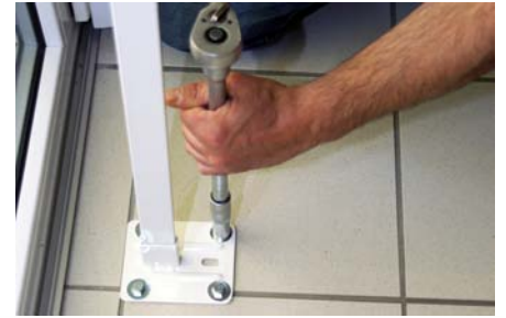
Standkonsolen mit beigefügten Dübeln und Schrauben befestigen
