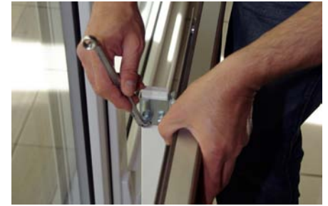
Glasheizkörper mittels der oberen Aufhängevorrichtung befestigen.
