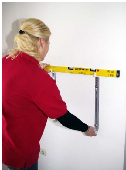
Wandhalterungen horizontal ausrichten
