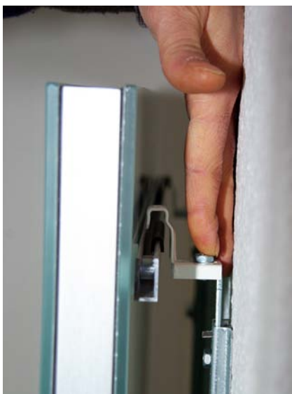
Glasheizkörper mittels der oberen Klammern der Wandhalterungen befestigen
