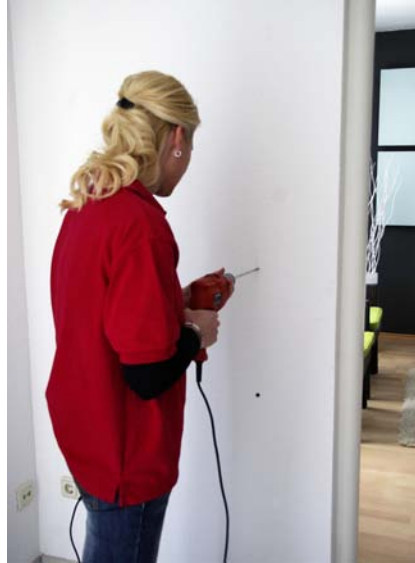
Bohrungen durchführen
