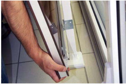
Glasheizkörper in die unteren Aufhängevorrichtung der Standkonsolen einhängen
