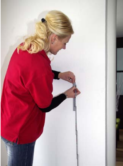
Position der Bohrlöcher ermitteln
