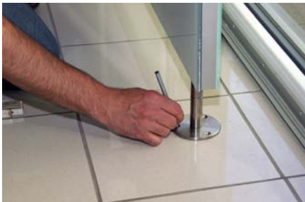
Position der Bohrlöcher ermitteln
