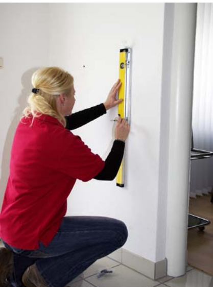
Wandhalterungen vertikal ausrichten
