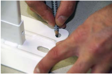
Position der Bohrlöcher ermitteln
