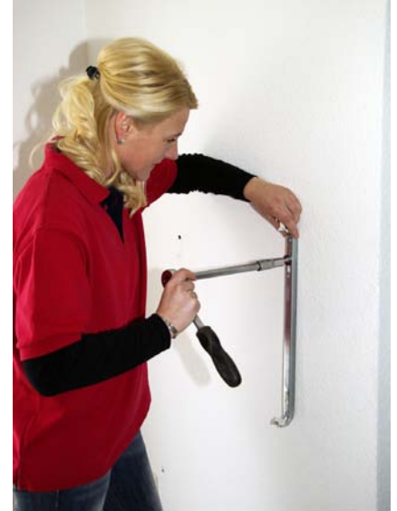
Wandhalterungen mit den beigefügten Dübeln und Schrauben befestigen
