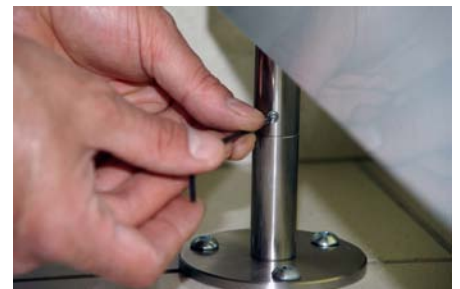
Zur Sicherung der Verbindung Madenschrauben festziehen
