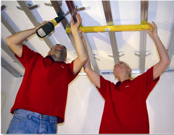
Montage einer Metallunterkonstruktion Installation of a substructure made of metal
