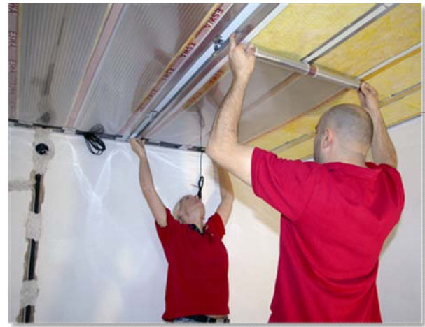
Folienmontage mit doppelseitigem Klebeband bei einer Metallunterkonstruktion On a substructure made of metal, fix the heating elements with a double-sided adhesive tape
