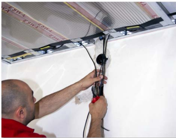
Elektrischer Anschl. Typ CC. Anschlussleitungen einzeln in die Anschlussdose führen Electrical connection of type CC. Put the connection cables separately into the terminal box
