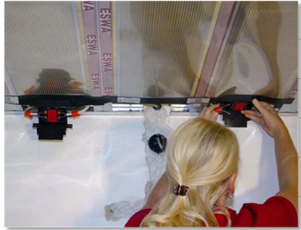
Elektrischer Anschluss Typ AC. Verbindung der Heizelemente in Parallelschaltung Electrical connection of type AC. Connection of the heating elements in a parallel circuit
