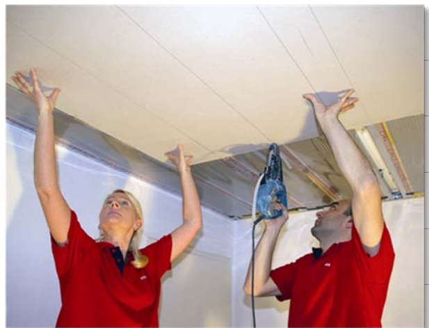
Achtung! Montage der Deckenverkleidung. Position der Unterkonstruktion markieren Important! When installing the ceiling lining make sure to mark the position of the substructure
