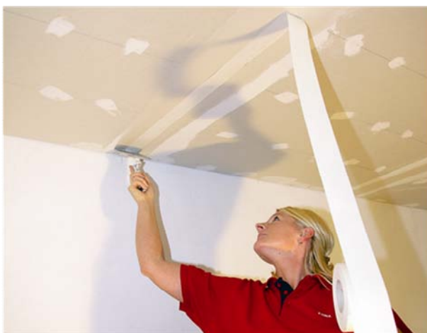
Achtung! Bei einer Deckenverkleidung aus Gipskarton unbedingt Fugenband einspachteln Important! Please use joint tape to fill the joints when using a ceiling lining made of plasterboard
