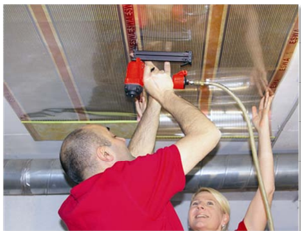
Folienmontage mit Klammern bei einer Unterkonstruktion aus Holz On a substructure made of wood, staple the heating elements to the lathing
